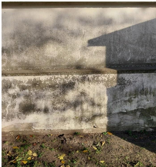
fot. 21 Radzyń Podlaski, mur zachodni, widok ścian narożnych przy bramie nr I widoczna zniszczona powierzchnia tynku pokryta nawarstwieniami i zielenicami z pierwszą fazą złuszczenia warstw tynków w przyziemiu, stan obiektu 2024 r.
