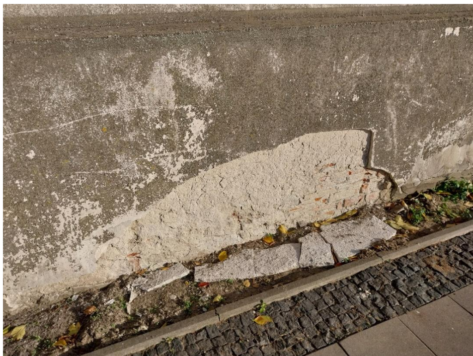
fot. 25 Radzyń Podlaski, mur zachodni, widoczne zniszczona powierzchni tynków z pierwszą i drugą fazą złuszczenia warstw tynków przyziemiu, stan obiektu 2024 r.
