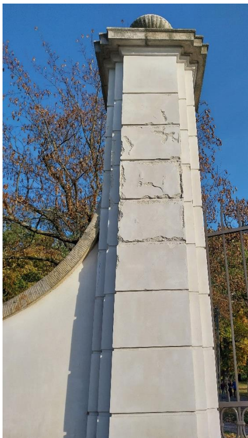
fot. 13 Radzyń Podlaski, Brama zachodnia oś Wschód Zachód, widok od ulicy Jana Pawła II, widoczne zniszczenie tynków na krawędziach boniowania, stan obiektu 2024
