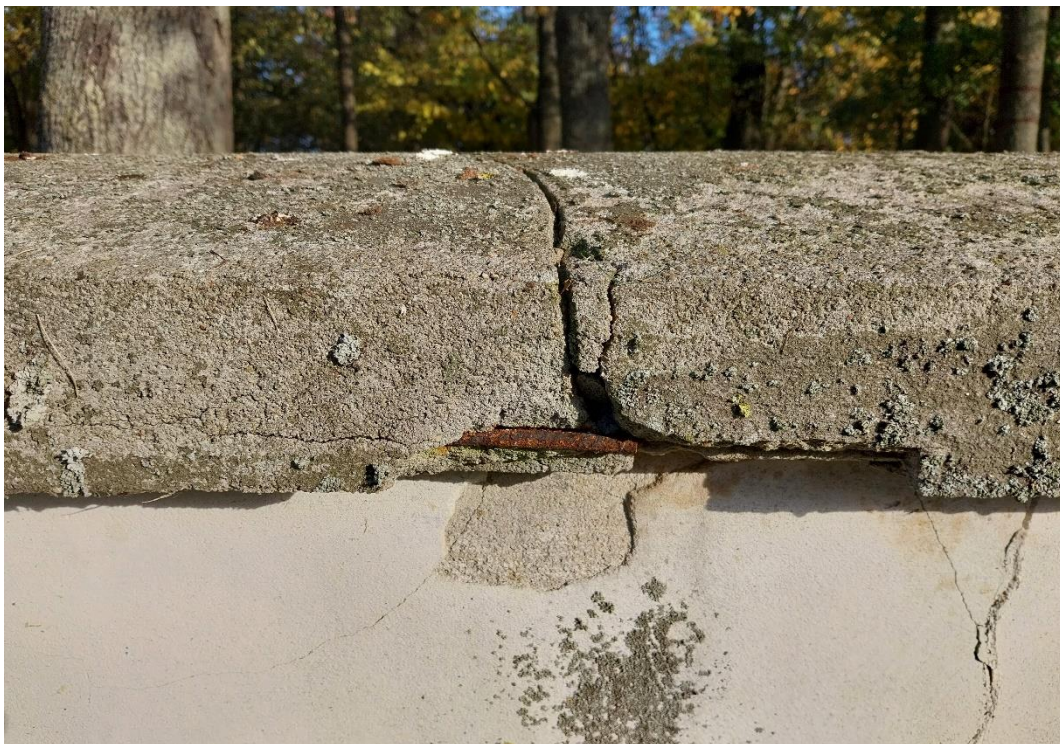
fot. 17 Radzyń Podlaski, mur zachodni, widok od strony ulicy Jana Pawła II, widoczne zniszczenia betonowej nakrywy, stan obiektu 2024 r.
