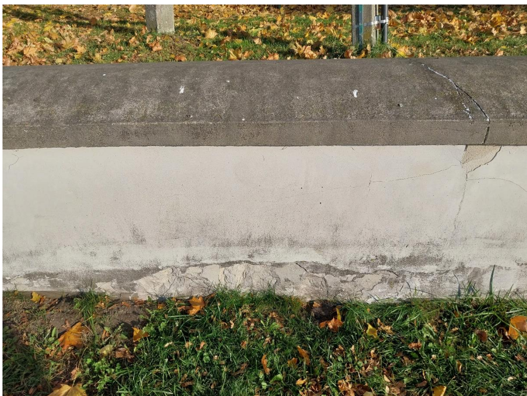
fot. 18 Radzyń Podlaski, mur zachodni, widok od strony ulicy Jana Pawła II, widoczne zniszczenia betonowej nakrywy,. Pęknięcia przenoszone na strukturę muru, stan obiektu 2024 r.
