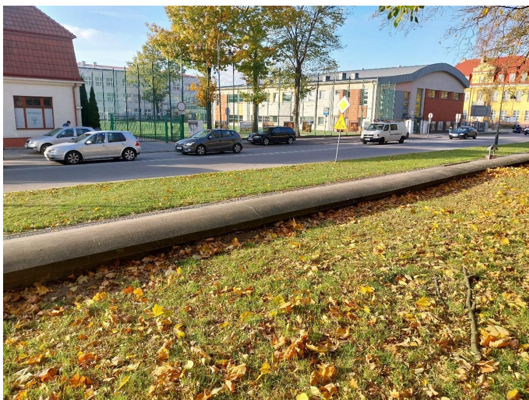
fot. 20 Radzyń Podlaski, mur zachodni, widok od strony parku, widoczne wysoki poziom gruntu pogrążający ścianę muru aż po nakrywę, stan obiektu 2024 r.
