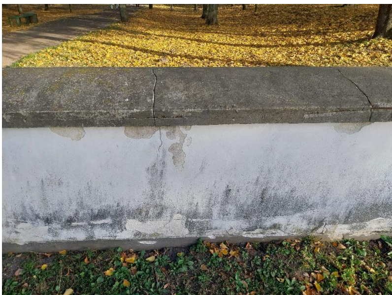
fot. 15 Radzyń Podlaski, mur zachodni, widok od strony ulicy Jana Pawła II, widoczne poprzeczne pęknięcia betonowej nakrywy, stan obiektu 2024 r.
