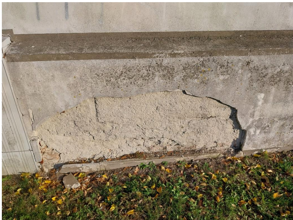
fot. 14 Radzyń Podlaski, mur zachodni, widok od strony ulicy Jana Pawła II, widoczne złuszczenia tynków, stan obiektu 2024 r.
